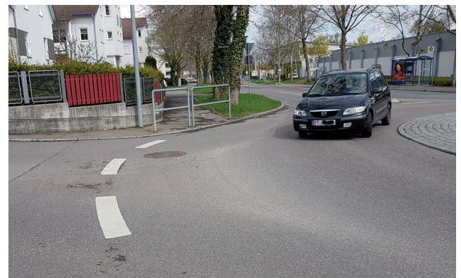
Radler am Aldi-Kreisel müssen entweder durch die enge Gehwegabspernung durch oder auf die Straße ausweichen.
